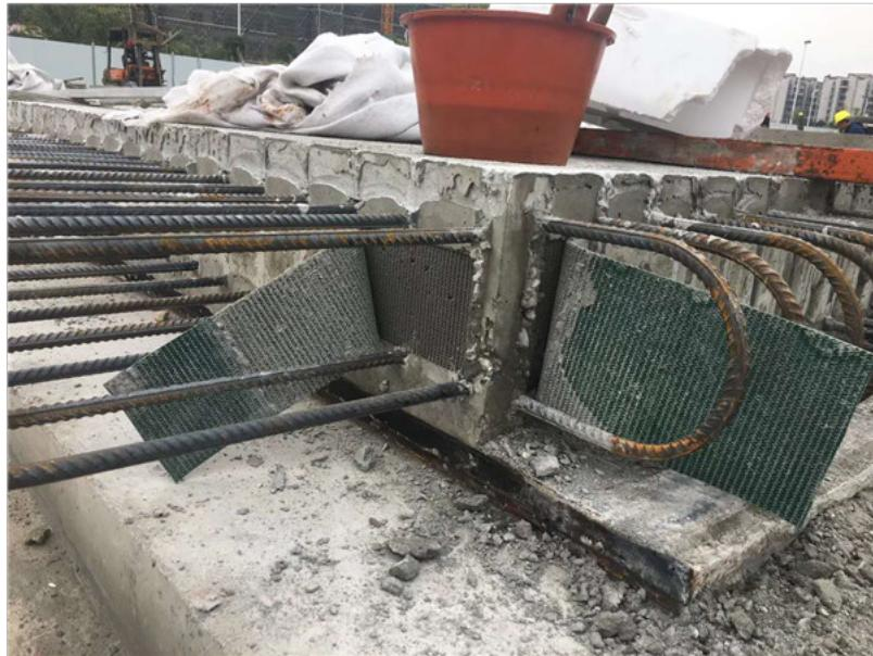
免凿毛止浆带一般是在桥梁施工或许加固时为了使新老混凝土交融的愈加完美而运用。在桥梁施工或加固工程时要使新老混凝土交融的愈加健壮需求扩大触摸面积运用到免凿毛止浆带，使平坦的毛面变成麻面，这样新老水泥就会交融的愈加健壮。而免凿毛深齿止浆带会让麻面孔的深度更大，使新老水泥交融的面积更广，作用更健壮。能够依据现场需求制作成各种尺度，施工起来愈加的便利、便利、漂亮，一起也能够重复运用。当运用免凿毛深齿止浆带时需求留意，在混凝土初凝后及时撤除止浆带防止过度凝固难以撤除，也不要过早撤除形成表层混凝土掉落。也不要拆的太晚，撤除太晚会难以撤除。免凿毛止浆带降低了施工成本，解决了人工和机械凿毛造成的困扰，施工起来更加的方便快捷。欢迎咨询。湖北免凿毛三角带购买
